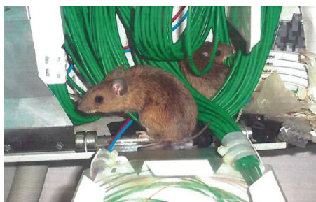
Rys. 1. Myszy obgryzające przewody światłowodowe
