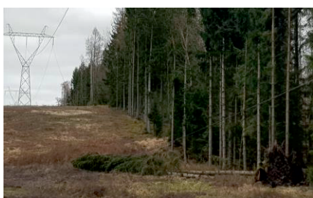
Rys. 7. Powalone drzewo na linię WN
